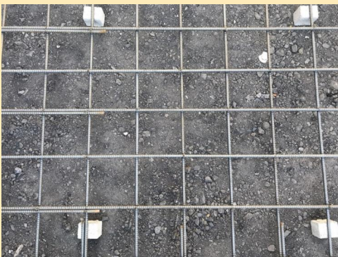
②基礎底盤部分の配筋状況等を確認できる写真
