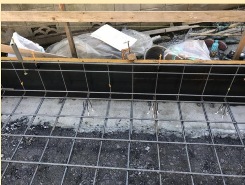
③基礎立上り部分の配筋状況等を確認できる写真
