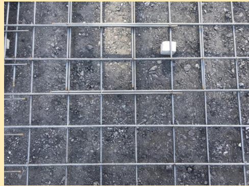
②基礎底盤部分の配筋状況等を確認できる写真
