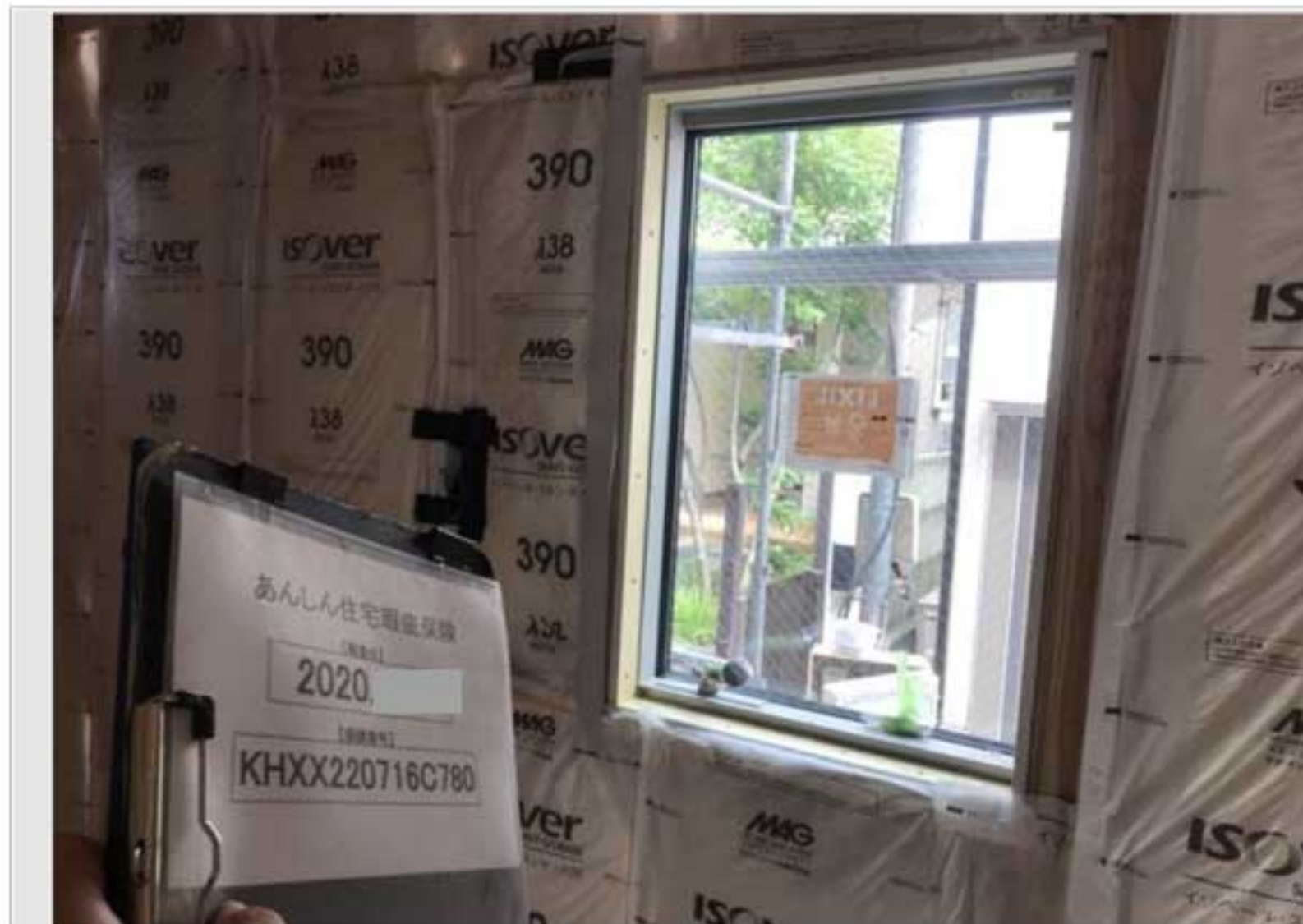
④ ④外壁：開口部廻り 断熱材の施工状況
