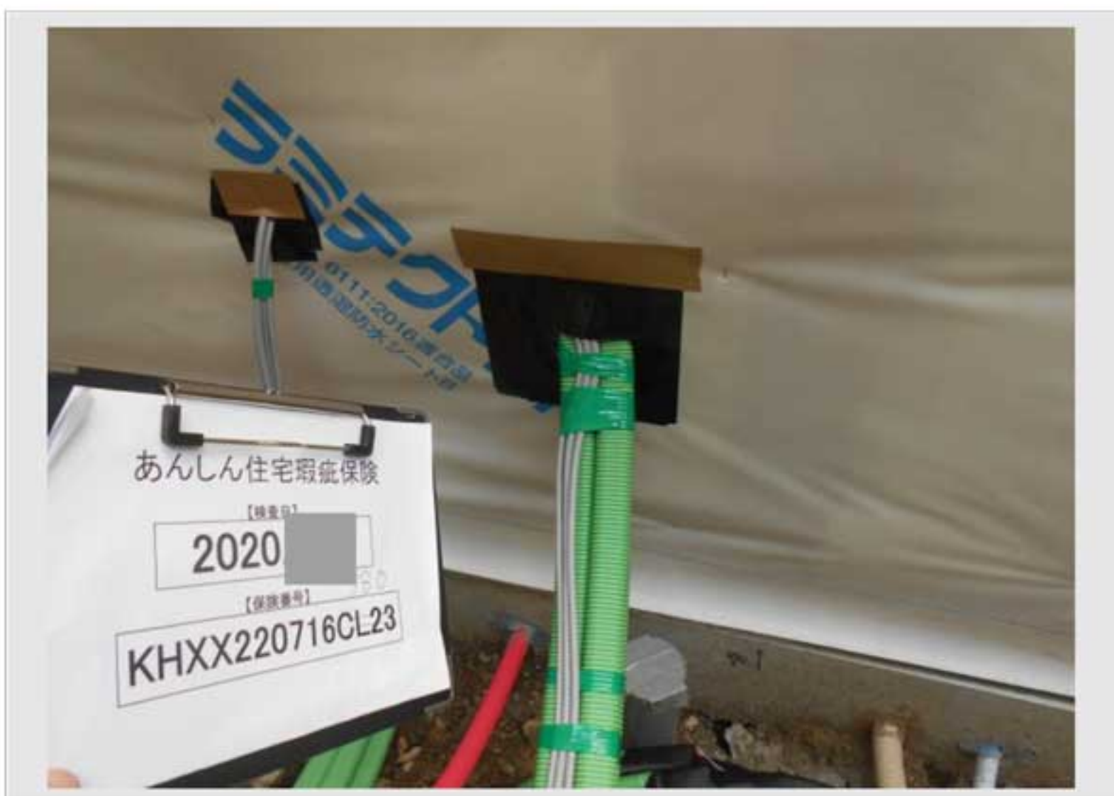
⑤貫通部の防水措置
