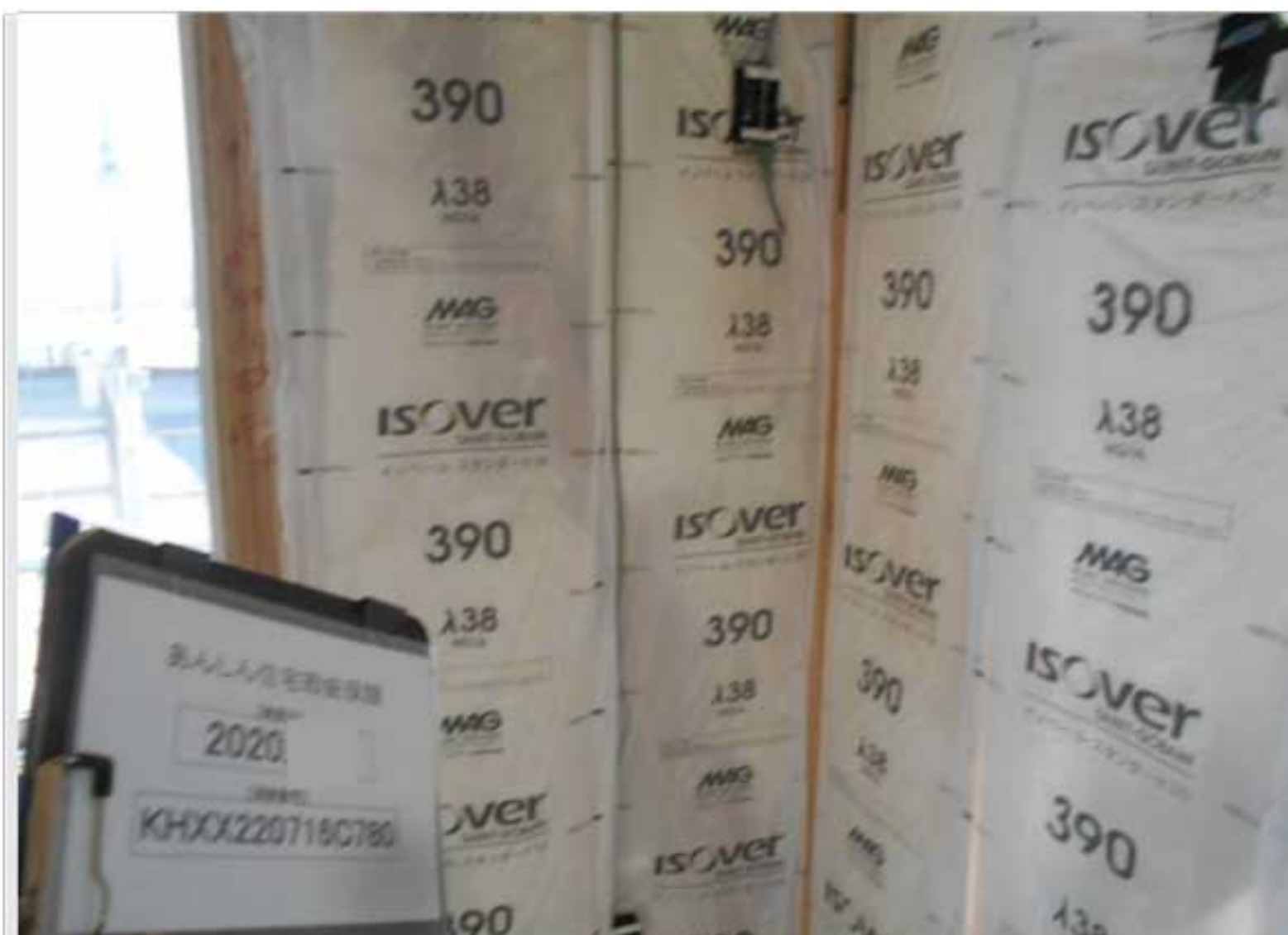
③外壁：筋かい部 断熱材施工状況
