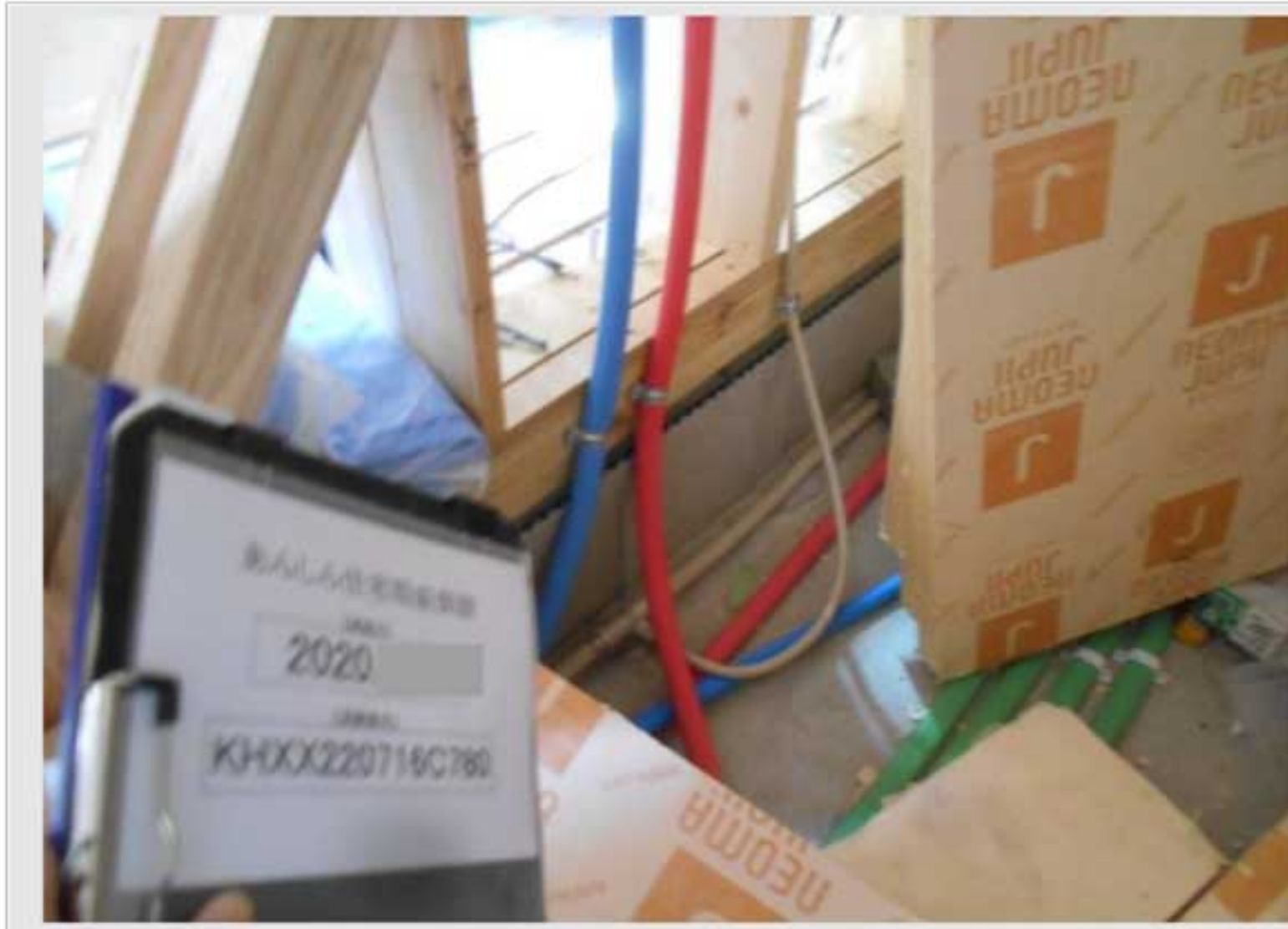
① 03土間・浴室廻り 断熱材の施工状況
