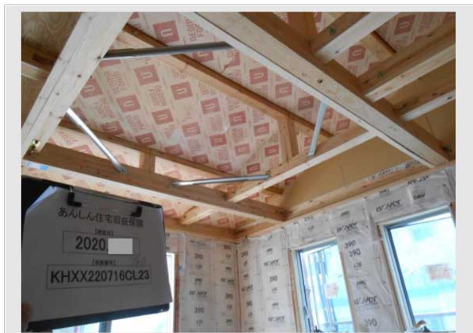
⑤小屋組材：設置状況
