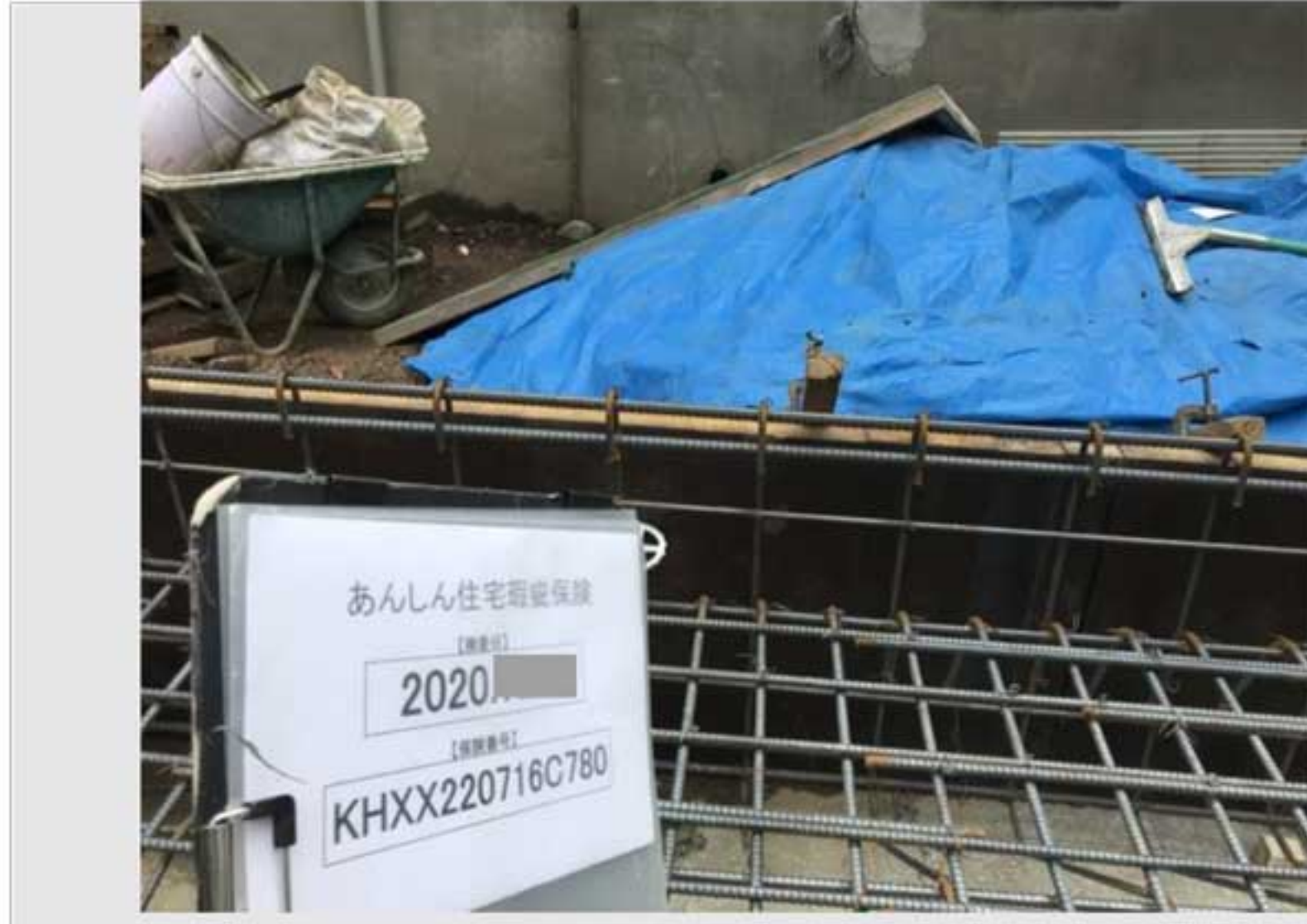
④立上り部分 配筋状況
