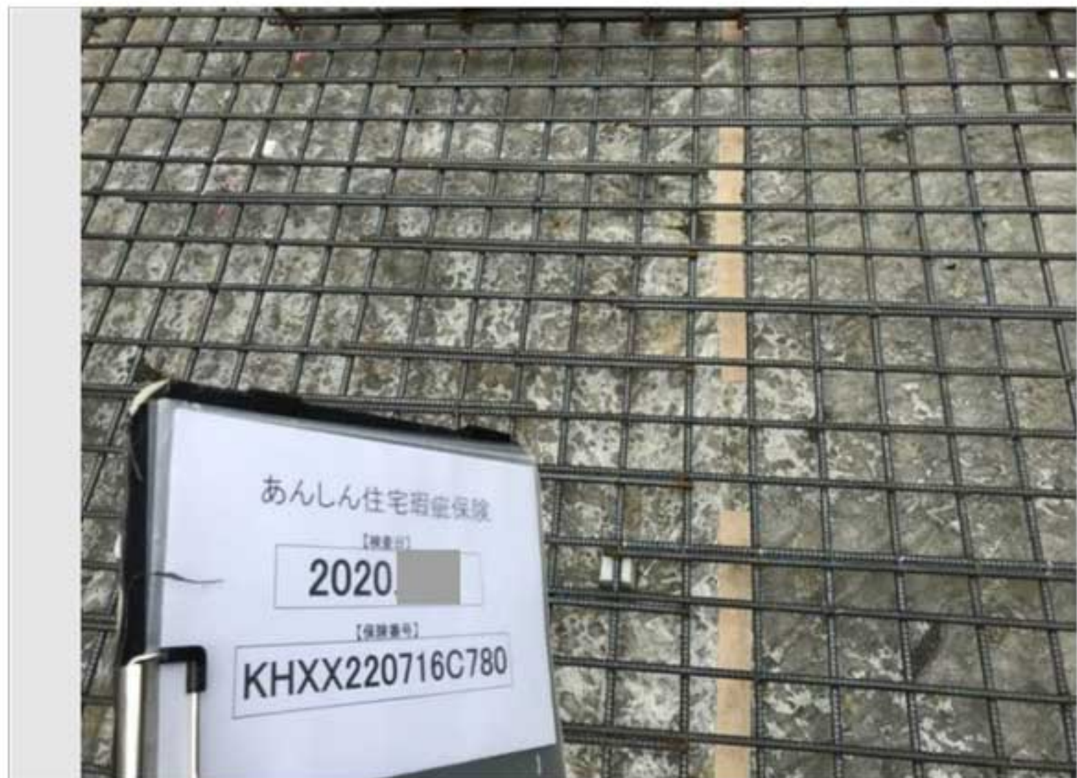
②底盤 配筋状況
