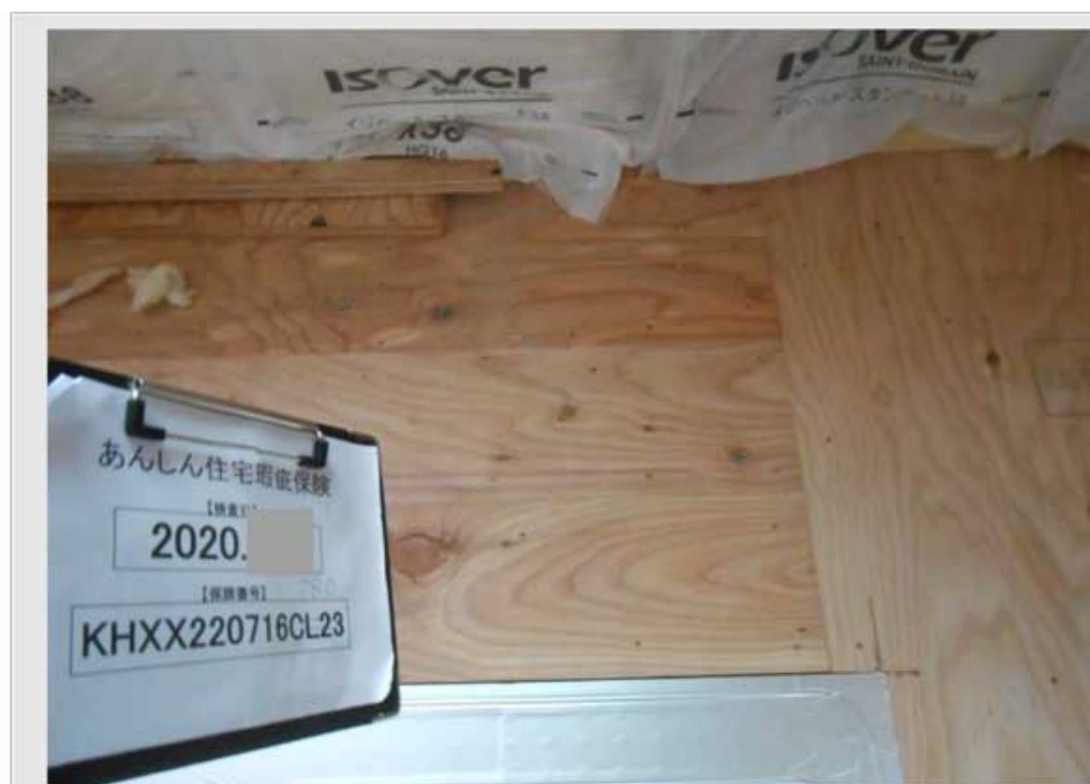
③床組：火打梁・面材床 設置状況
