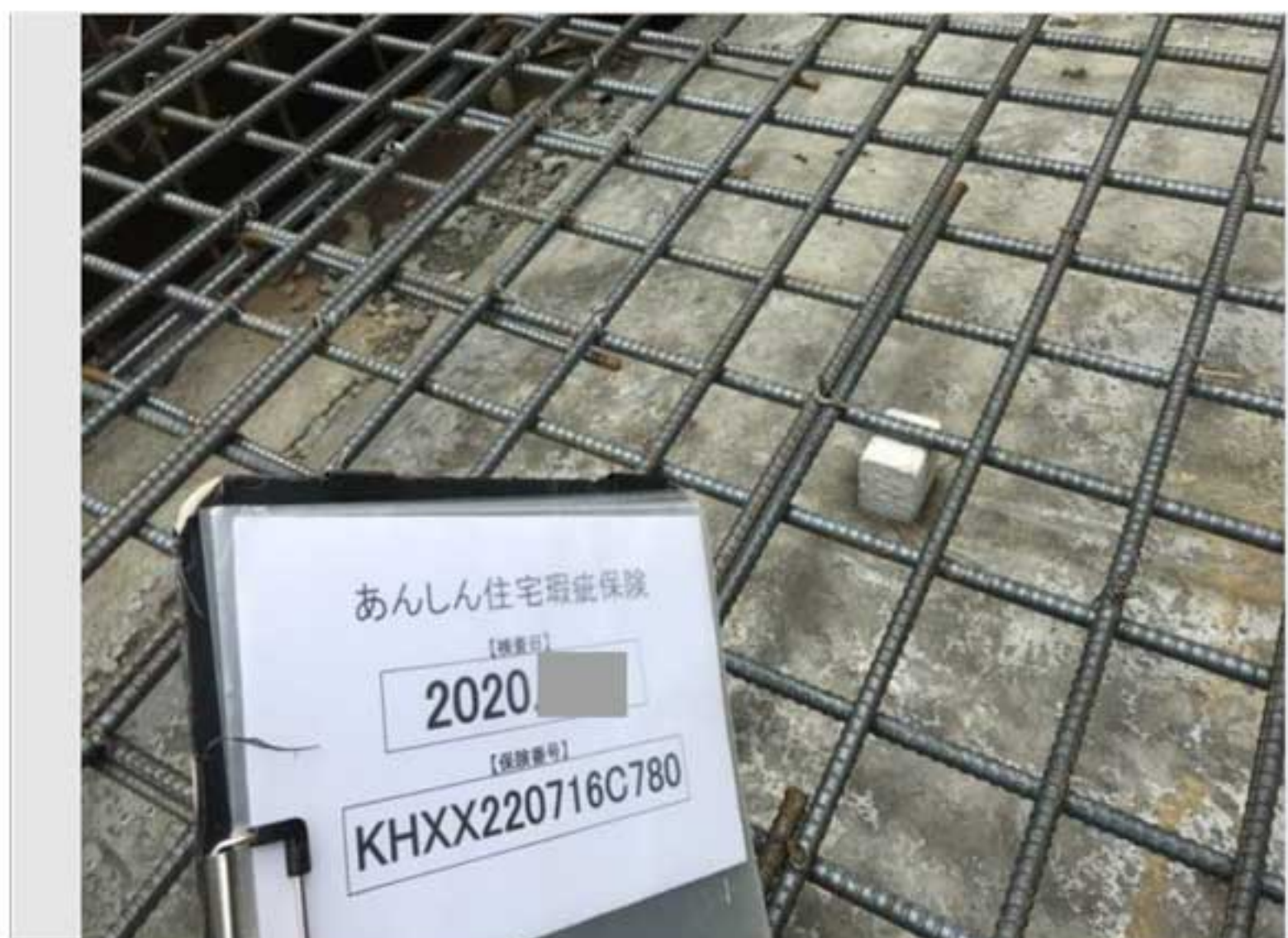
③底盤スパーサー 設置状況
