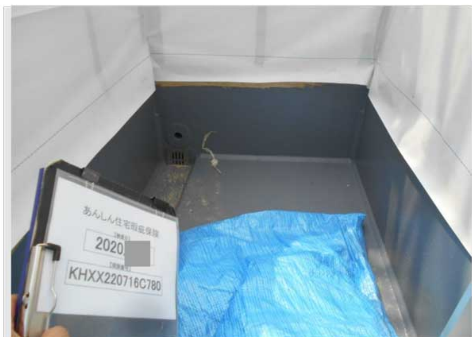
⑥ ⑥バルコニー ：掃出しサッシ下端の 立上り部 防水施工状況
