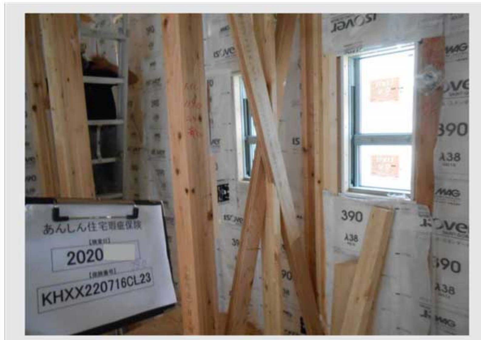
④耐力壁：筋かい・面材 設置状況
