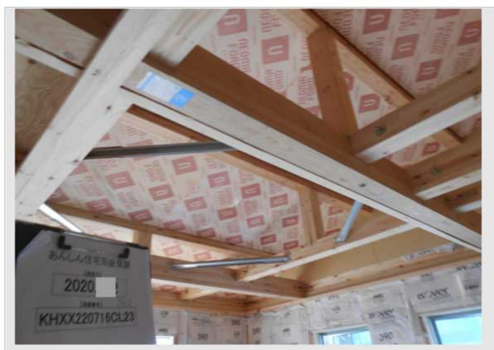
⑨小屋組材 取付状況
