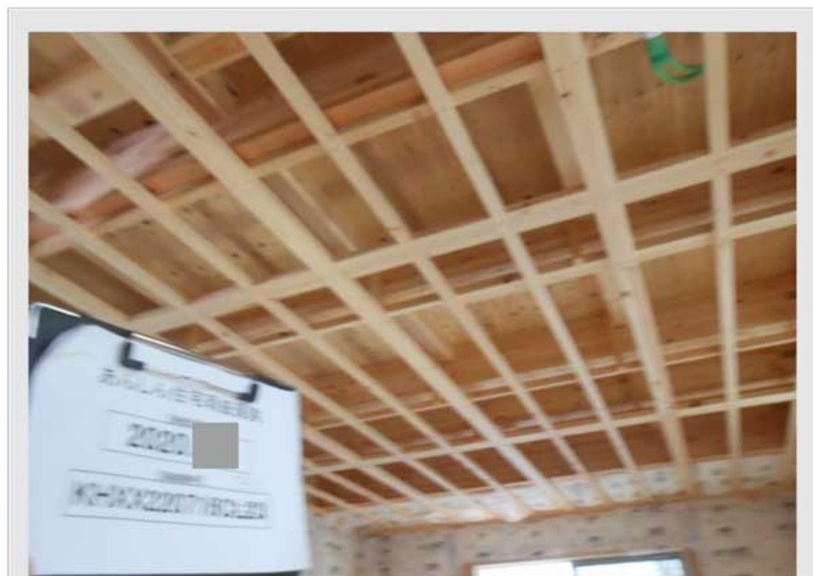
⑧横架材 取付状況
