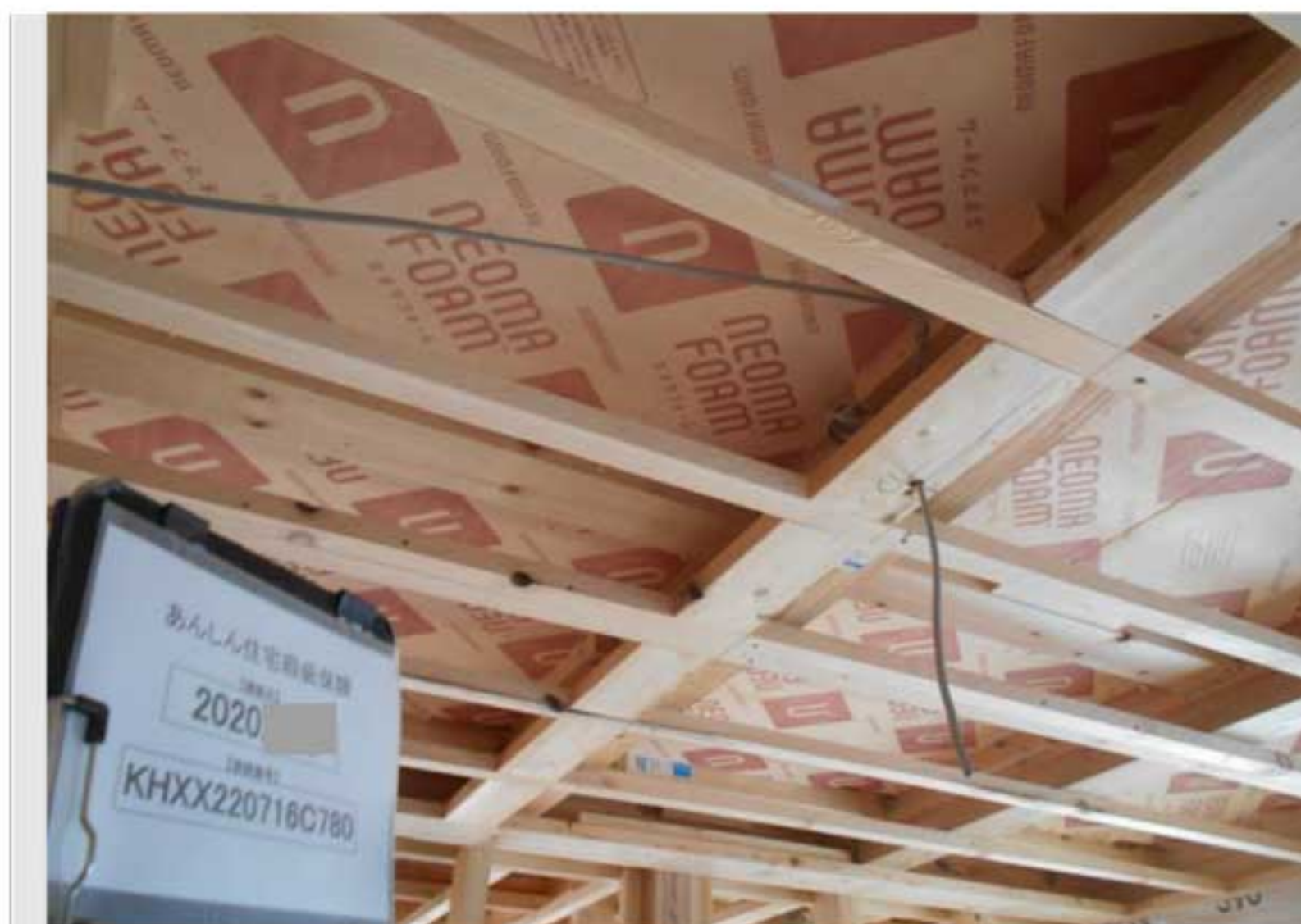
⑤ ⑤屋根・天井 断熱材施工状況
