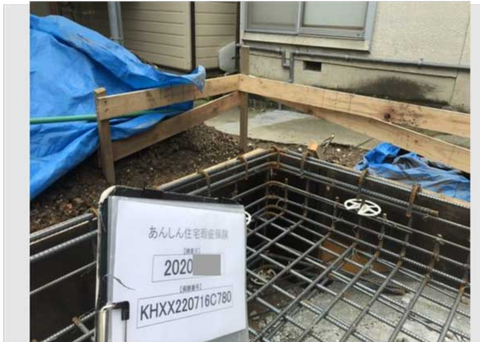
⑤立上り部分 継手状況
