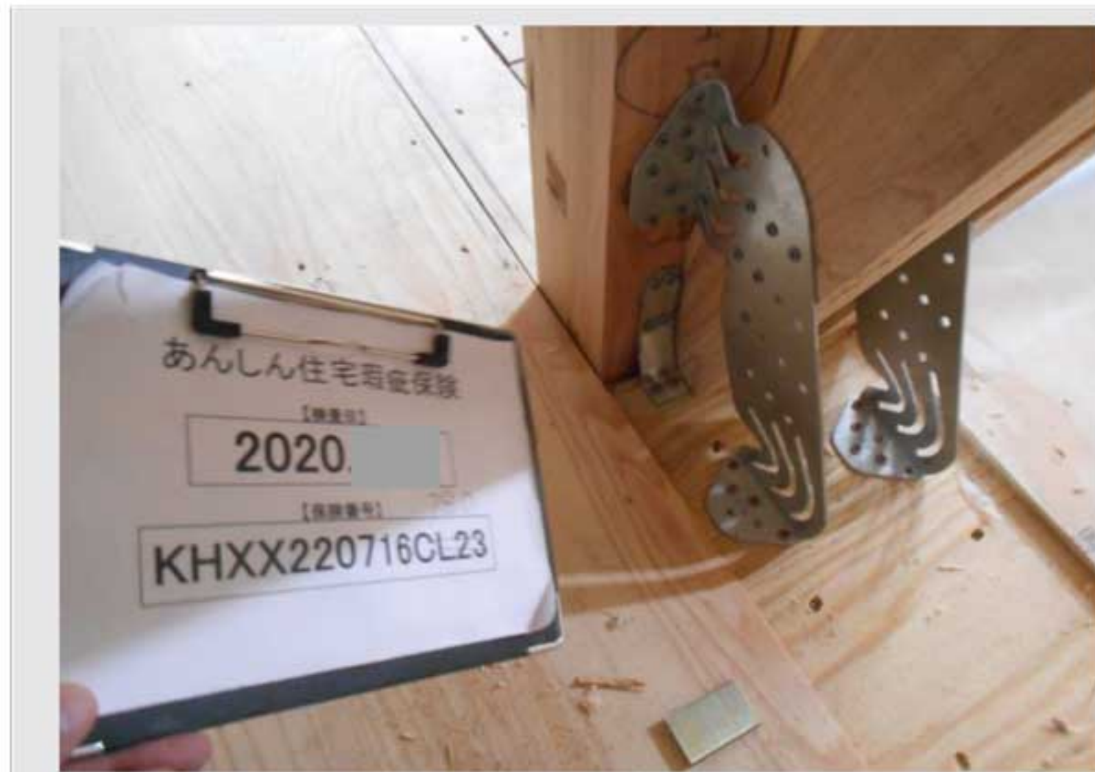
⑦筋かい端部 取付状況
