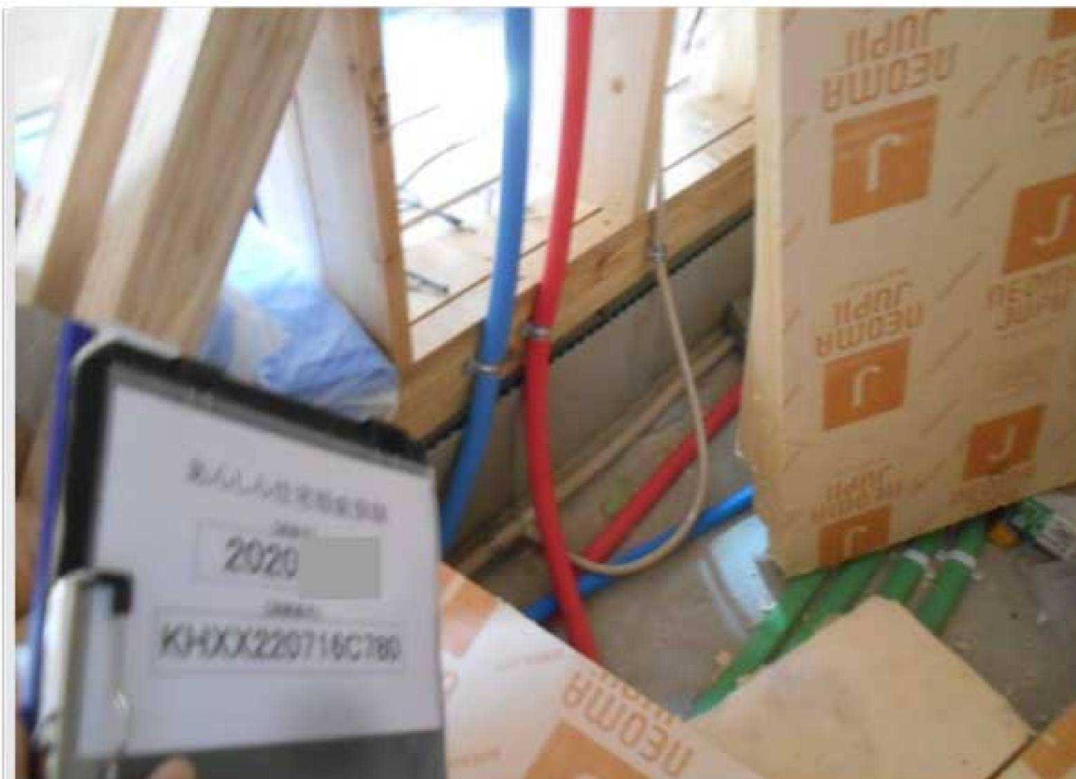
②床：浴室廻り 断熱材施工状況
