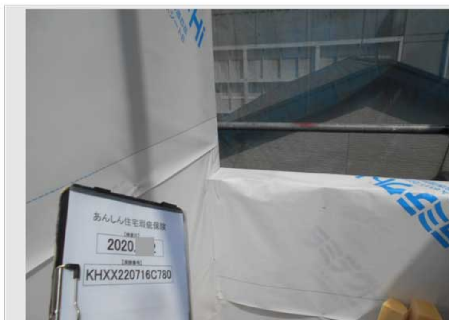
③ 外壁と手すり壁の取り合い部
