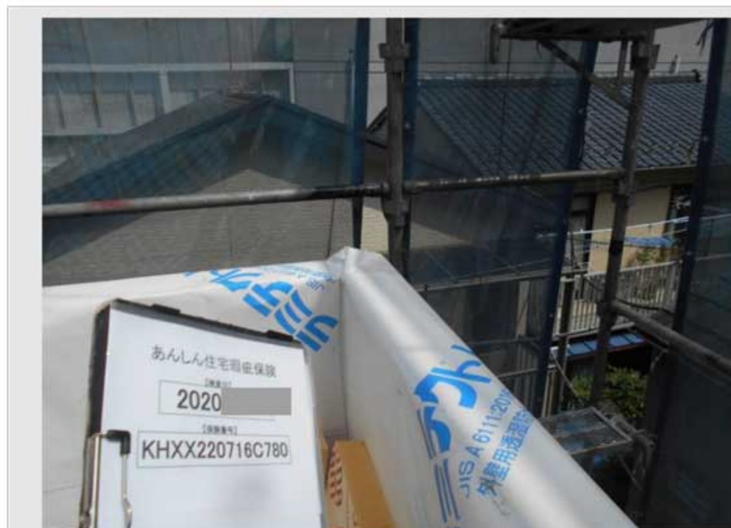
① バルコニー手すり壁天端
